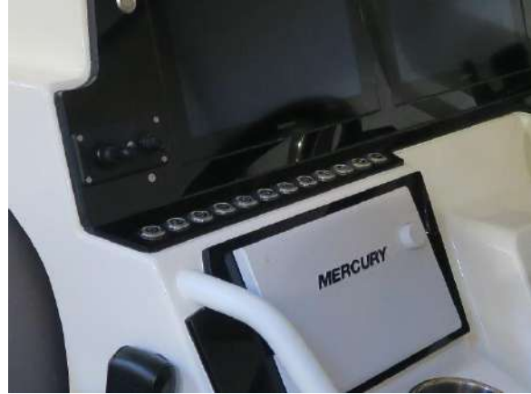
Interrupteurs du poste de pilotage
