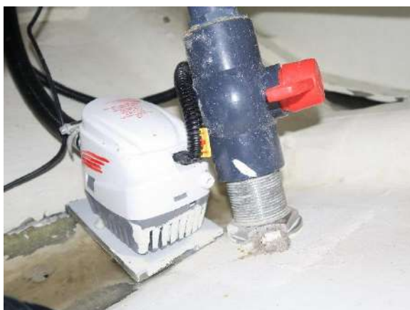
Valvola di scarico
