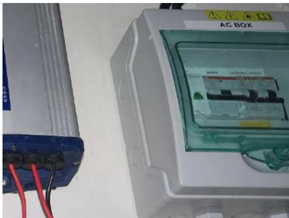
Disyuntores diferencial y principales
