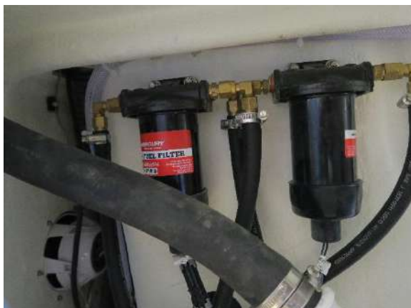
Filtros de combustible
