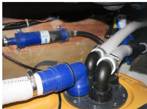
Depósito de aguas negras
